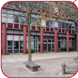
Glaspavillon (R12 S00 H12) Universitätsstraße/Ecke Gladbecker Straße, 45141 Essen
